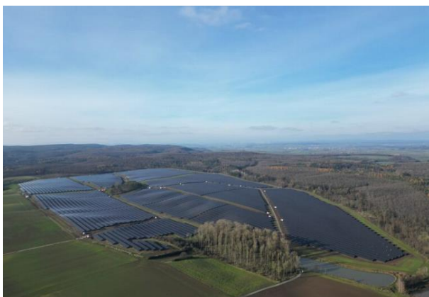
Blick von oben (© MaxSolar GmbH ( https://sonne-sammeln.de/felderchen-singen-im-buergersolarpark-bundorf/ ))
